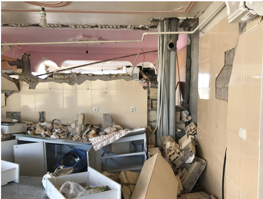
فروریختن دیوار داخلی در سازه بتن آرمه ۷ طبقه مسکن مهر
