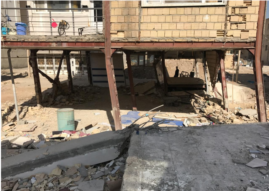
تغییر شکل ستون‌ها از تراز کف اول ناشی از طبقه نرم
