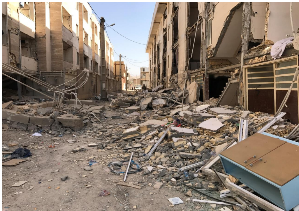
فروریختن دیوار پیرامونی در سازه فولادی ۳ طبقه
