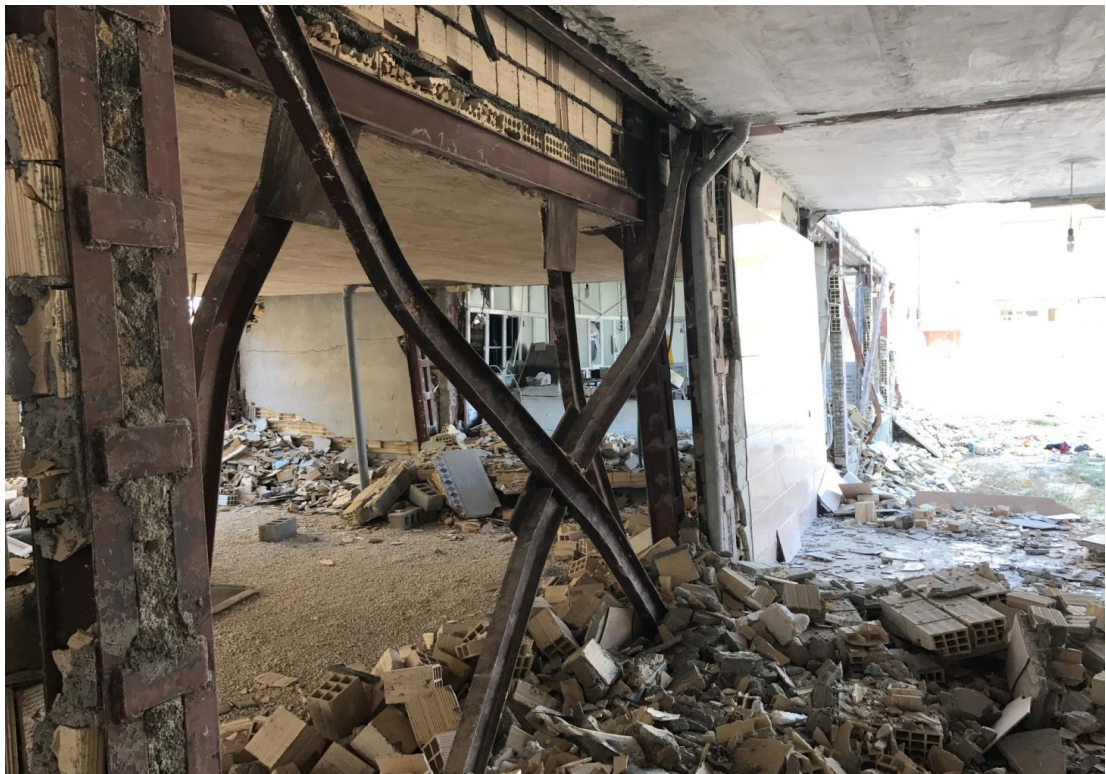
کمانش مهاربند تک پروفیل
