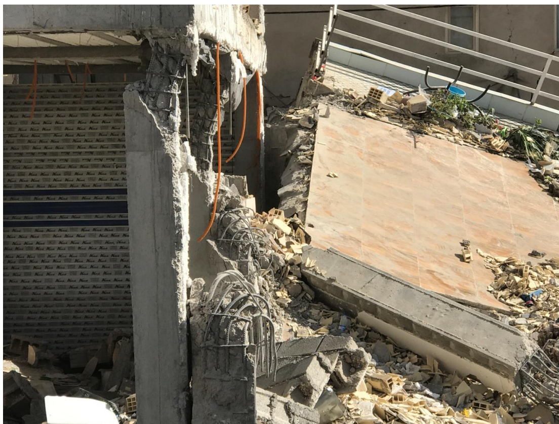
فروریزش کامل ساختمان بتن آرمه
