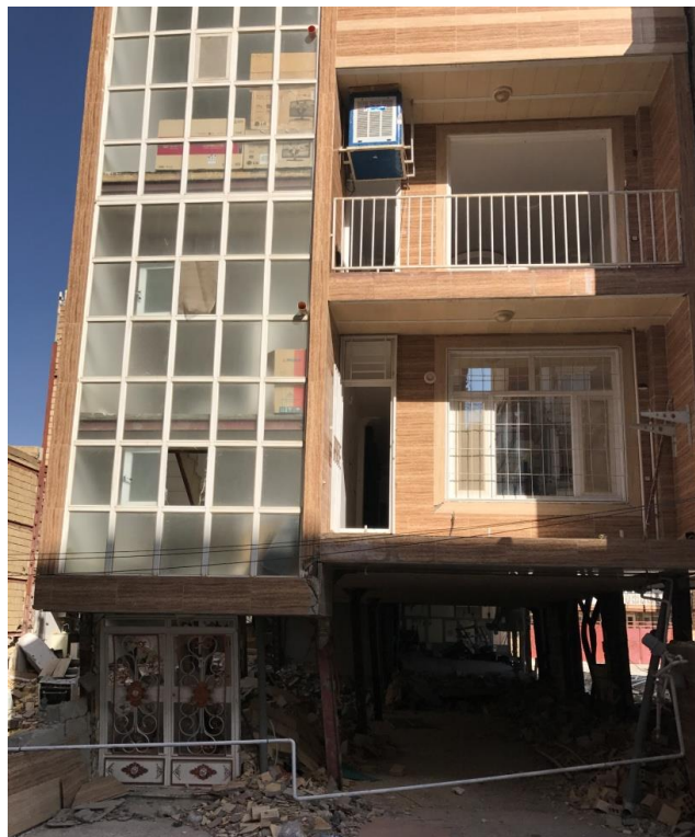
تغییر شکل ستون‌ها از تراز کف اول ناشی از طبقه نرم
