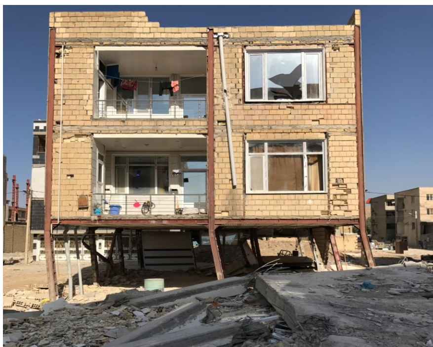
عملکرد نامناسب سازه فولادی دارای سیستم قاب خمشی و بادبندی در دو جهت متفاوت
