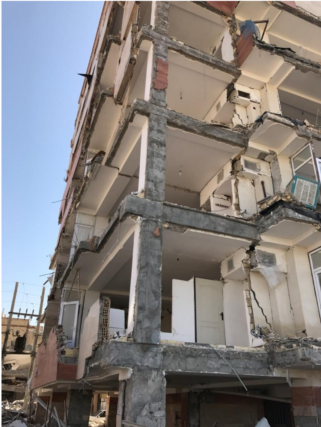
فروریختن دیوار پیرامونی در سازه بتن آرمه ۷ طبقه مسکن مهر
