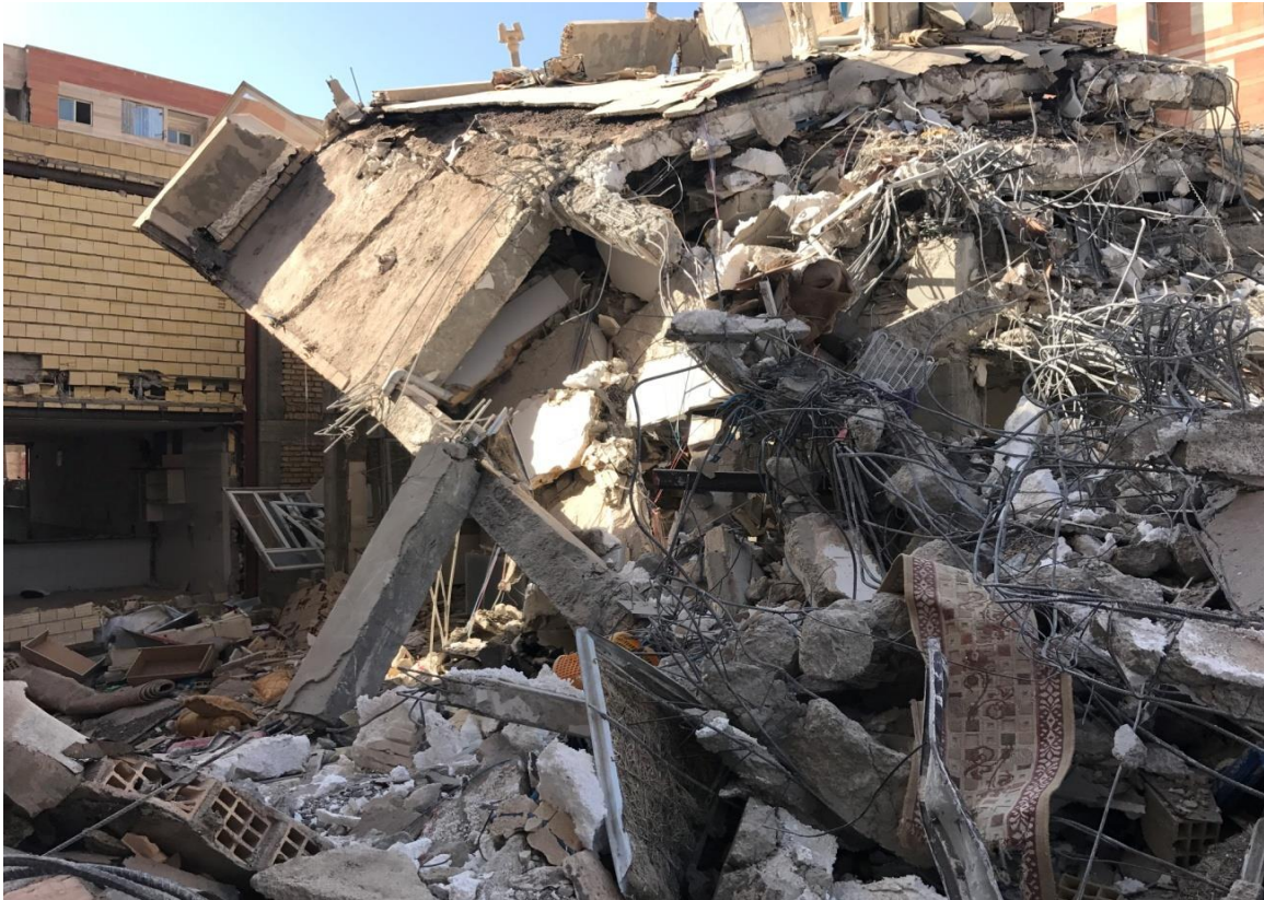
فروریزش کامل ساختمان بتن آرمه
