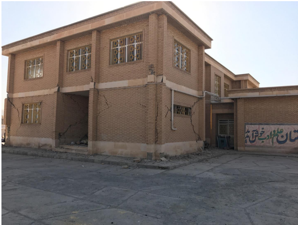
ترک ایجادشده در ساختمان دارای دیوار باربر آجری
