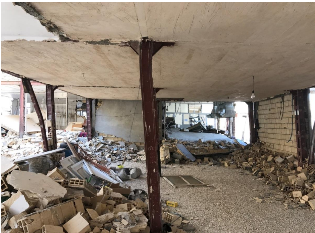
تغییر شکل ستون‌ها از تراز کف اول ناشی از طبقه نرم
