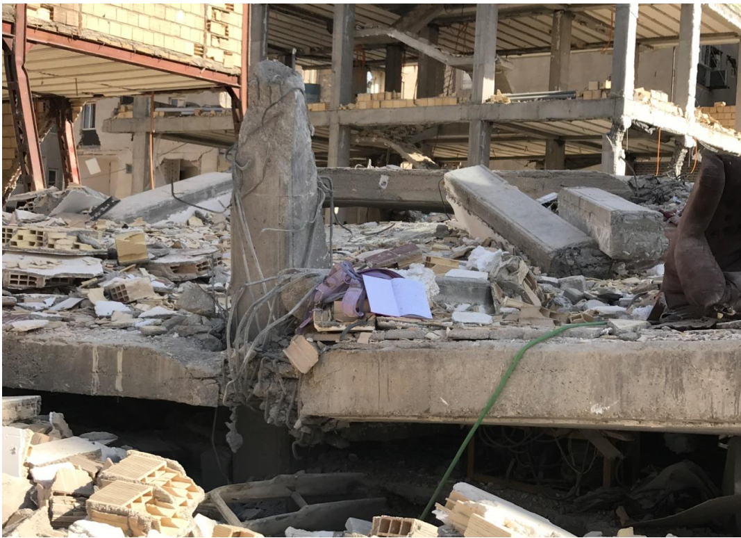
فروریزش کامل ساختمان بتن آرمه
