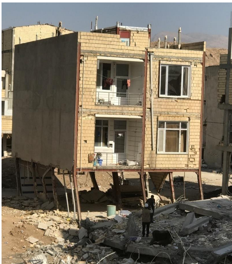
تغییر شکل ستون‌ها از تراز کف اول ناشی از طبقه نرم
