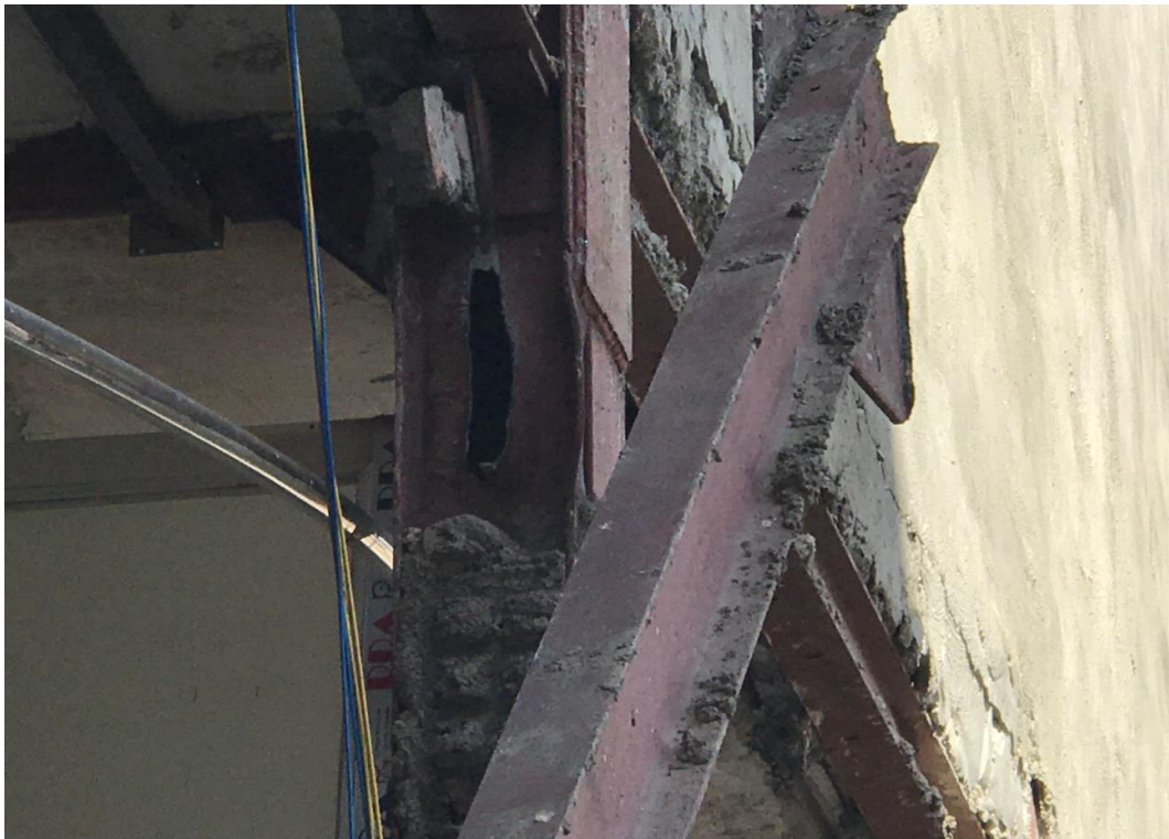
پاره شدن ورق در محل اتصال صفحه اتصال مهاربندی
