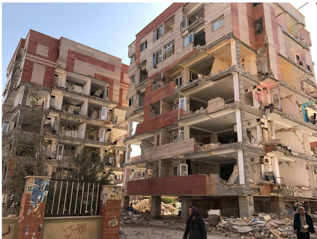
تخریب مسکن مهر
