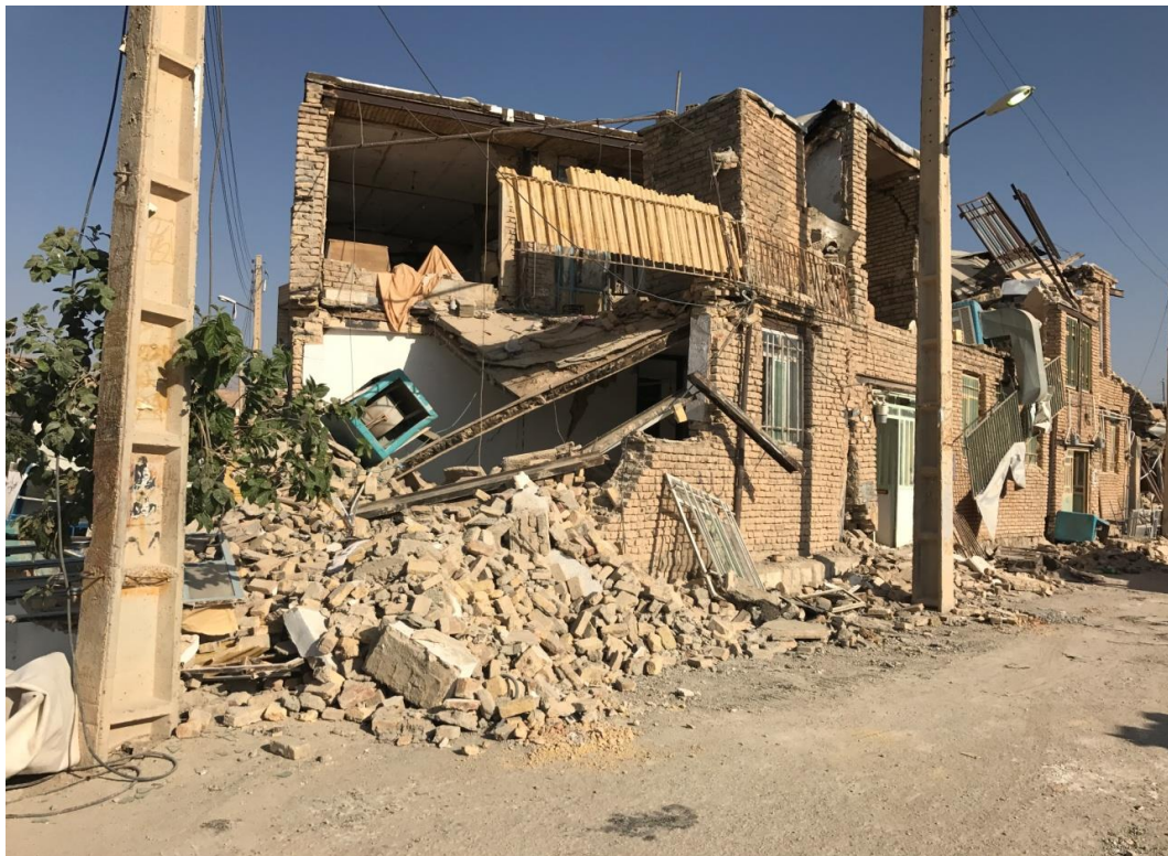
فروریزش ساختمان دارای دیوار باربر آجری و اجزای فولادی
