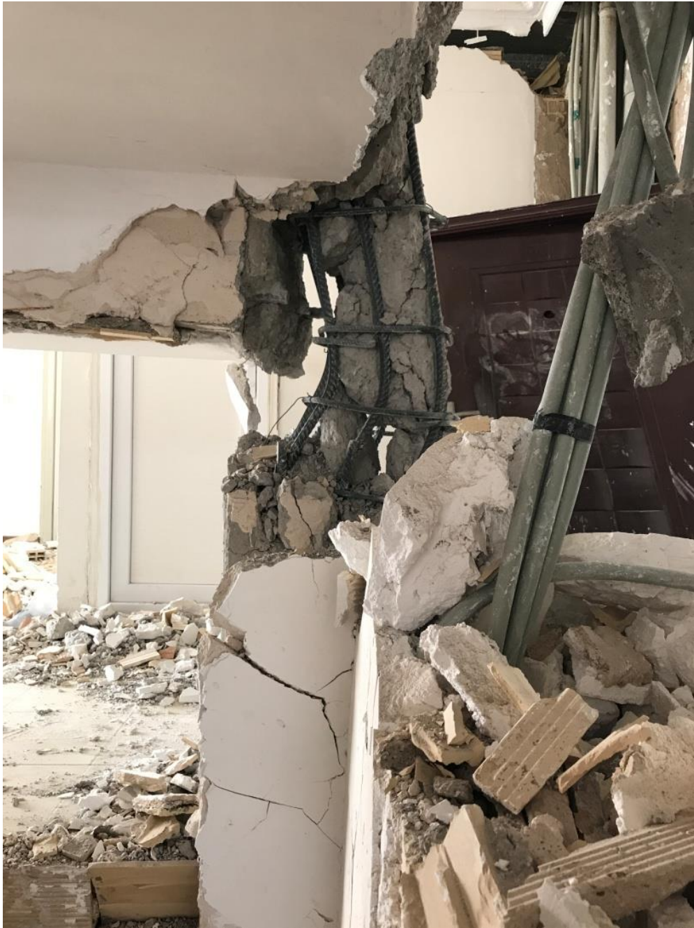
ایجاد ستون کوتاه در راه پله در محل اتصال تیر میان طبقه
