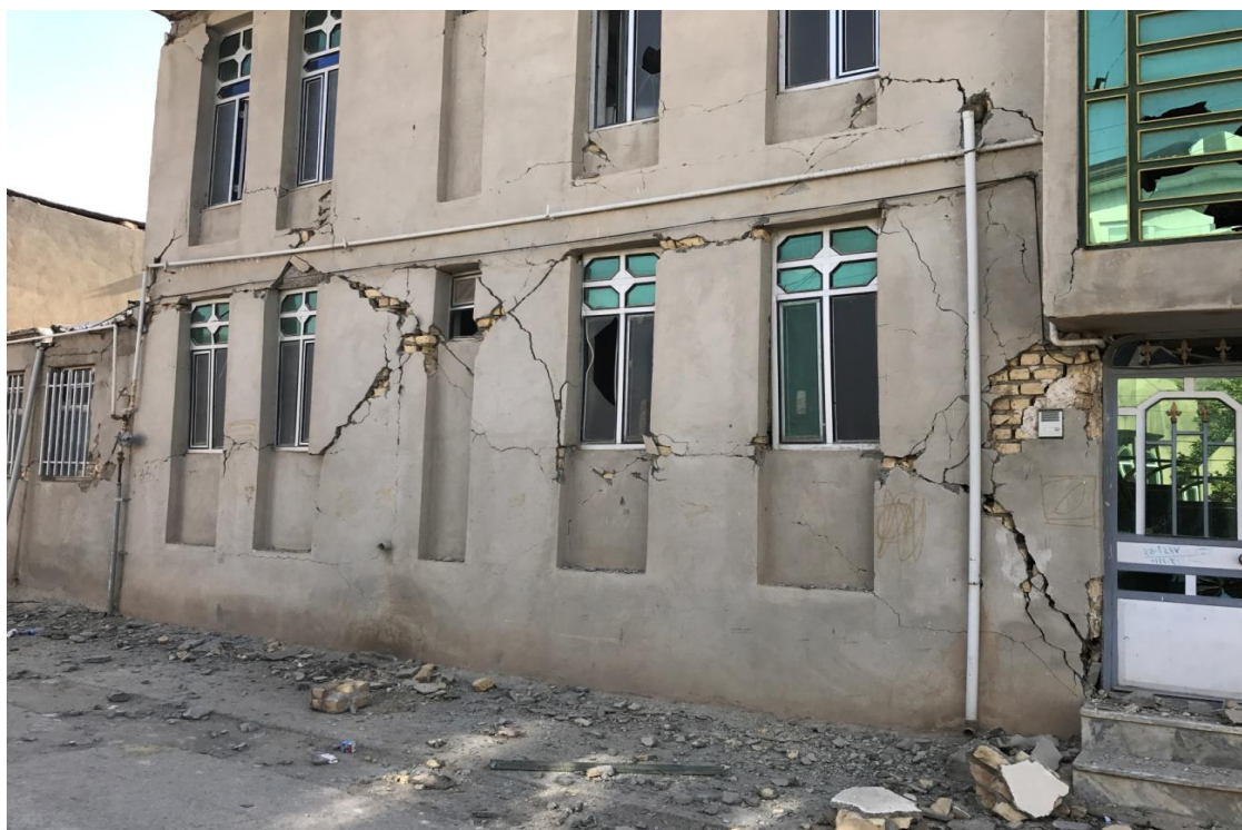
آسیب دیوارهای اطراف بازشو و شناژ قائم در ساختمان دارای شناژ
