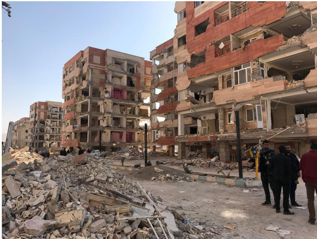
تخریب مسکن مهر
