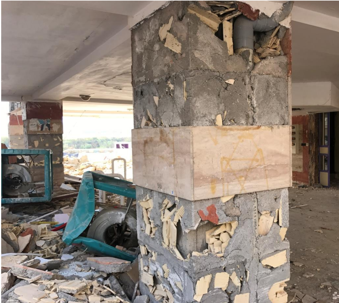
استفاده از دوغاب با خرده سفال پشت سنگ پلاک در مسکن مهر
