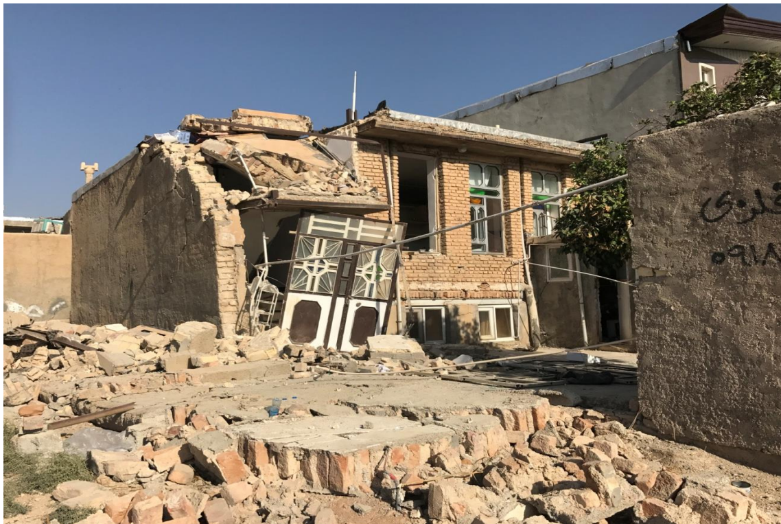
فروریزش ساختمان دارای دیوار باربر آجری و اجزای فولادی
