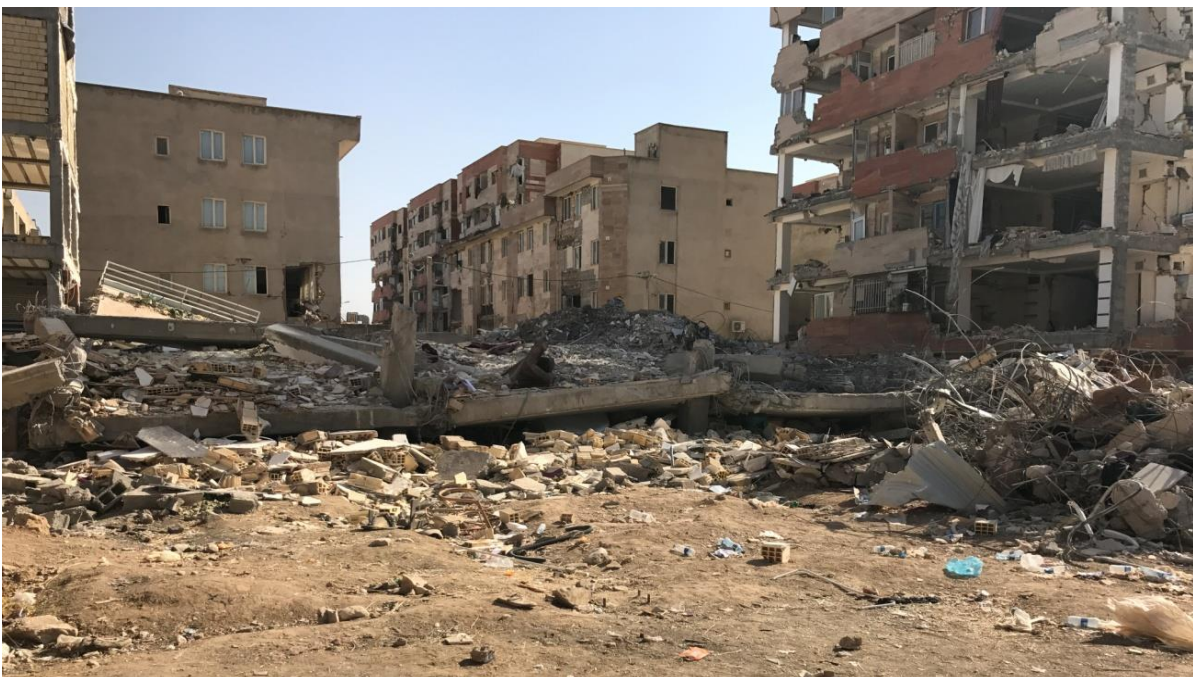
فروریزش کامل ساختمان بتن آرمه
