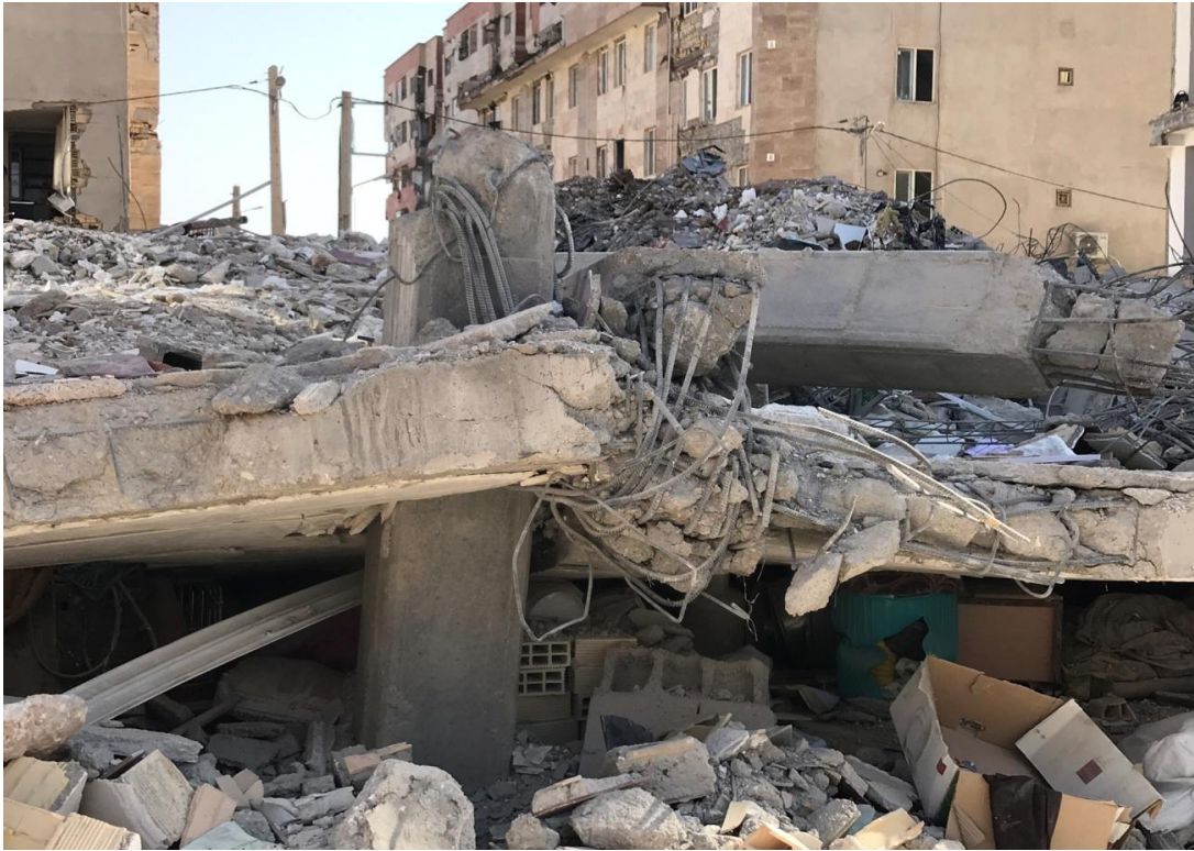
فروریزش کامل ساختمان بتن آرمه
