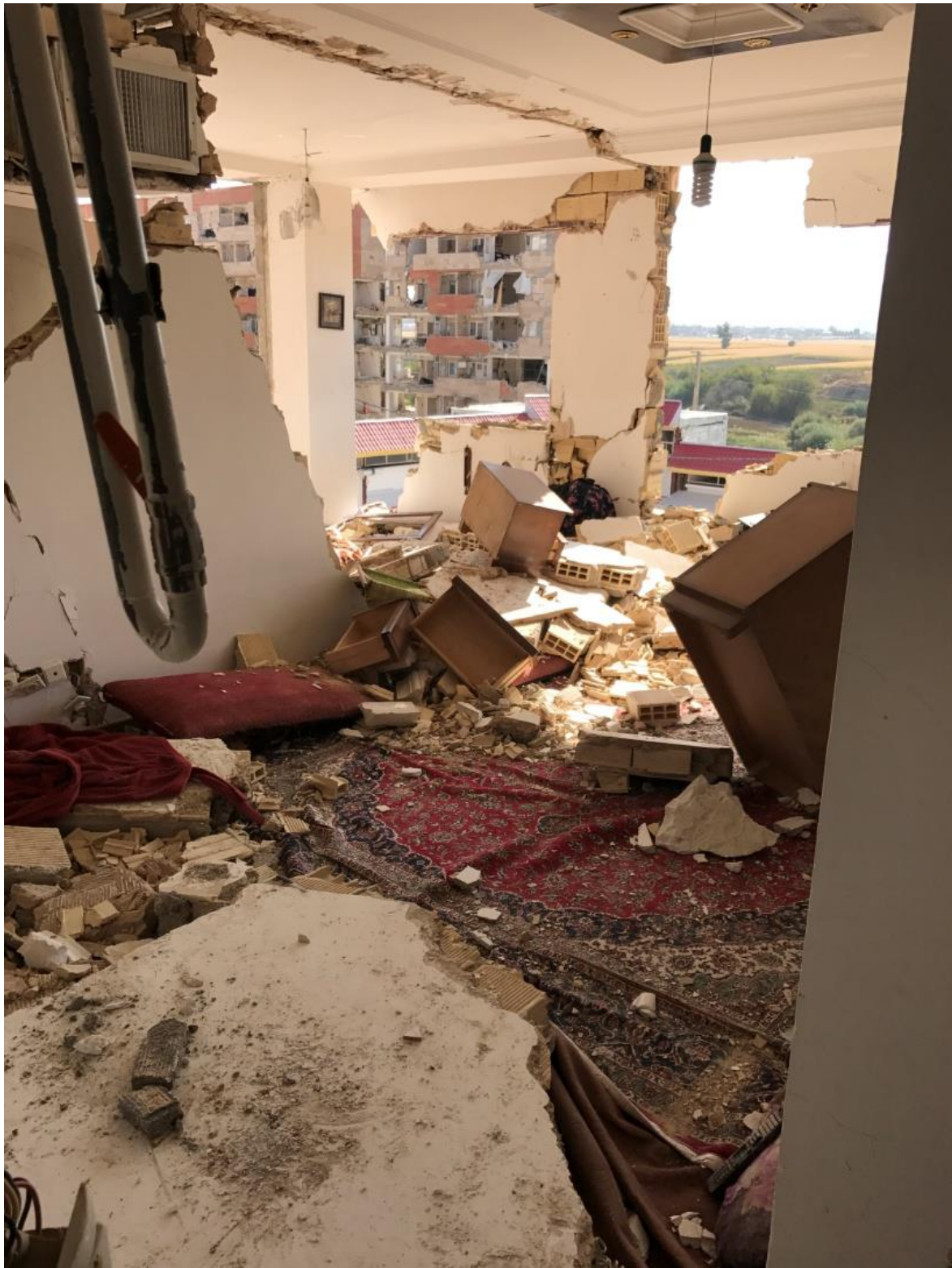
فروریختن دیوار داخلی و پیرامونی در سازه بتن آرمه ۷ طبقه مسکن مهر
