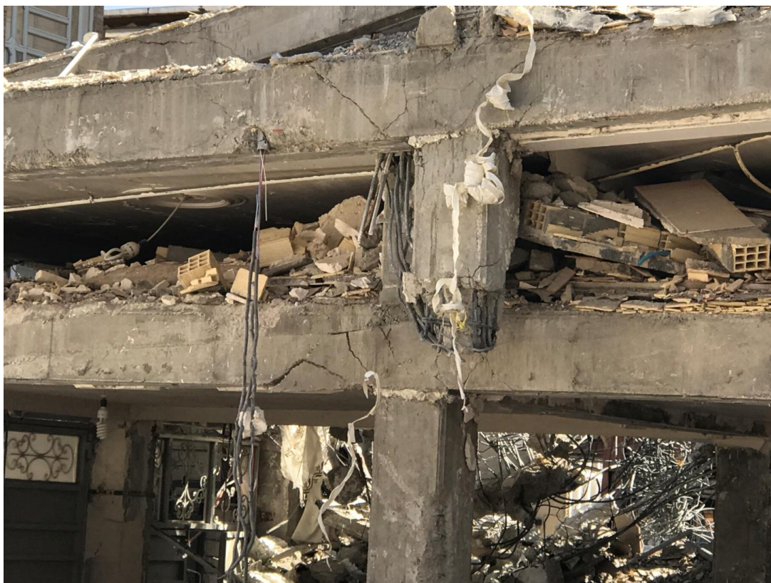
فروریزش کامل ساختمان بتن آرمه
