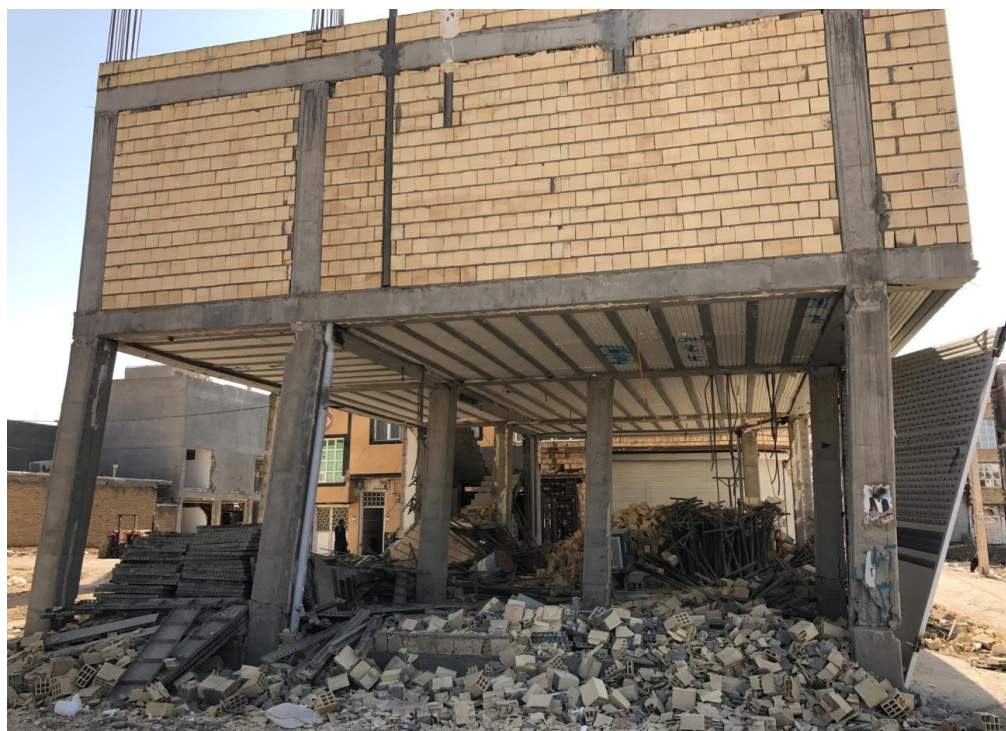
تشکیل مفصل پلاستیک در بالا و پایین ستون‌ها و دررفت زیاد طبقه پیلوت
