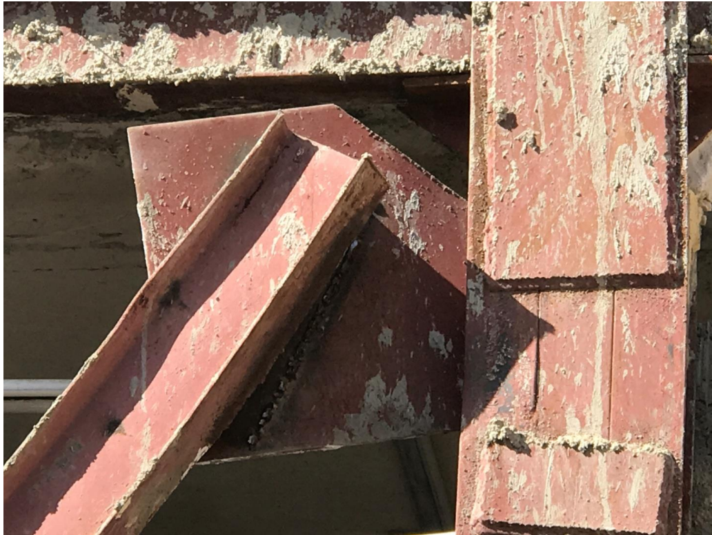
عدم اجرای جوش در سطح فوقانی صفحه اتصال
