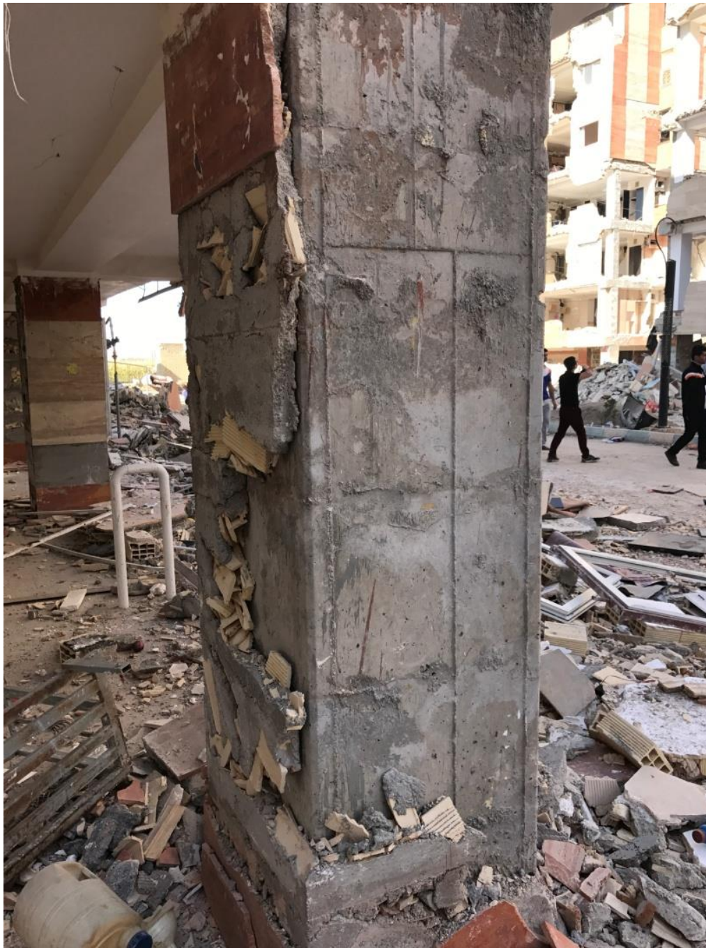
استفاده از دوغاب با خرده سفال پشت سنگ پلاک در مسکن مهر
