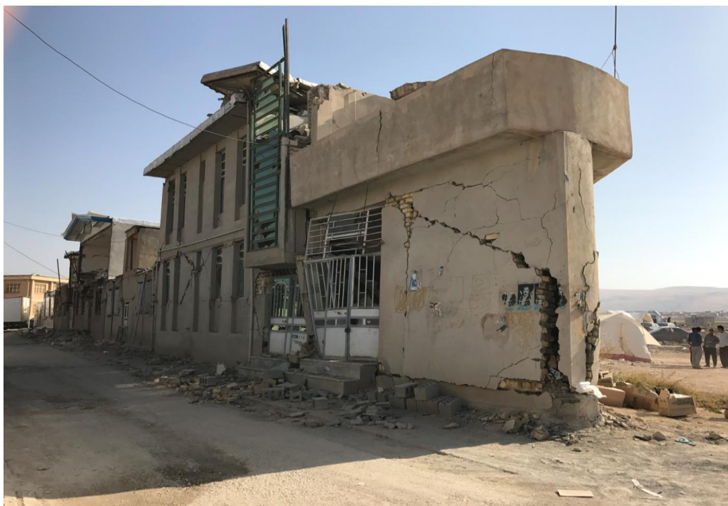
ترک ایجادشده در ساختمان دارای دیوار باربر آجری
