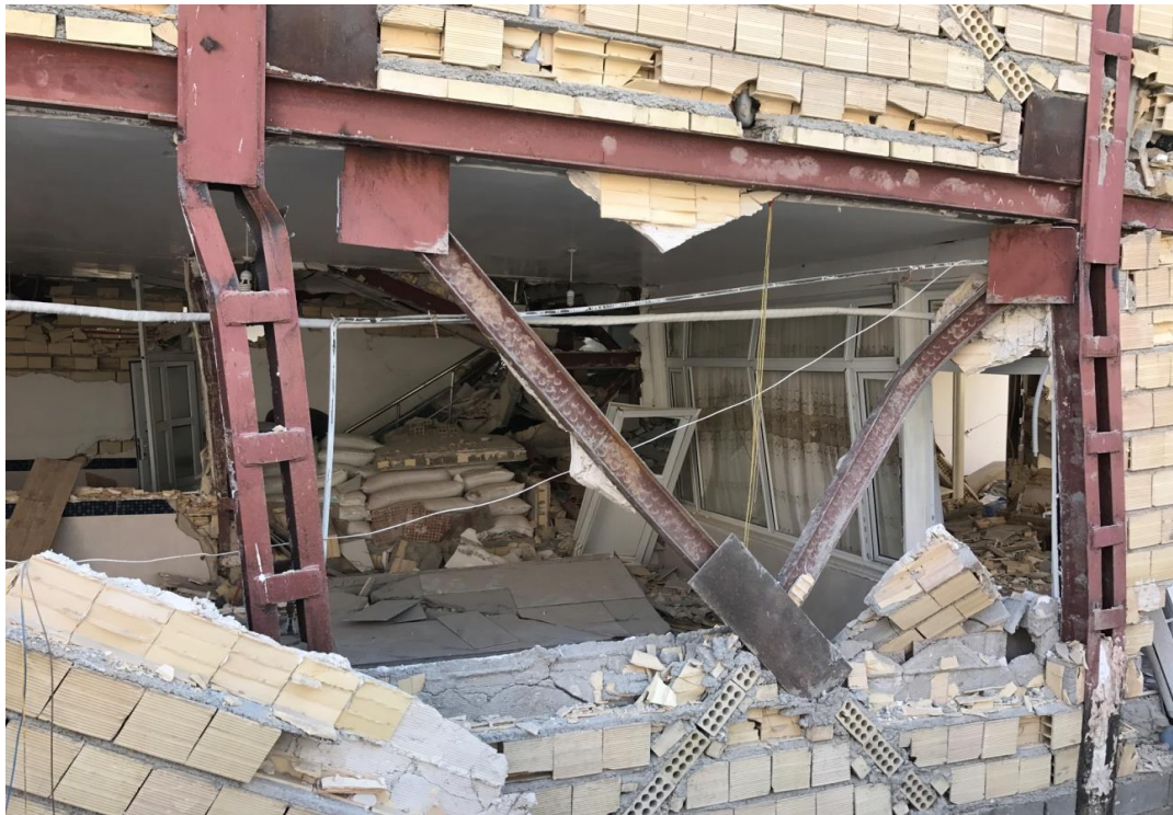
کنده شدن ورق اتصال صفحه اتصال مهاربندی و کمانش ستون دارای بست افقی
