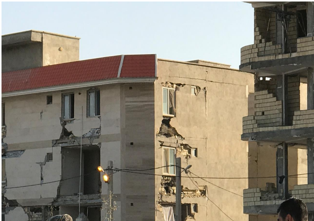
خرابی دیوار غیر سازه‌ای
