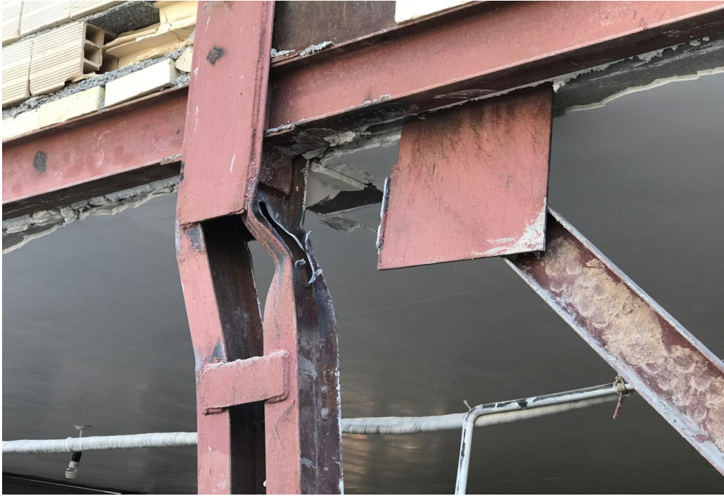
پاره شدن ورق در محل اتصال صفحه اتصال مهاربندی
